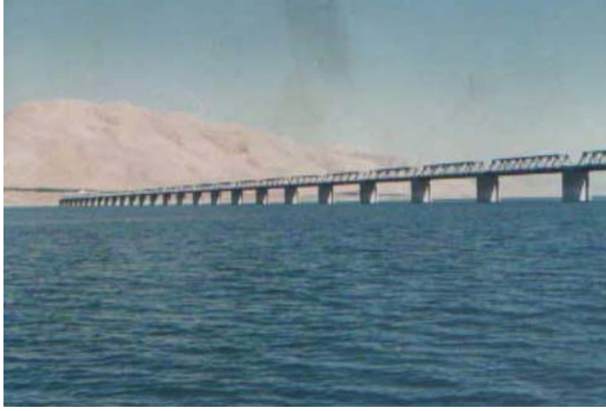
Resim 1. Karakaya Barajı Demiryolu köprüsü
