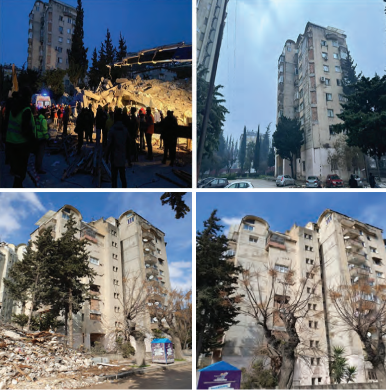
Deprem sonrası durum ve dış görünüş
