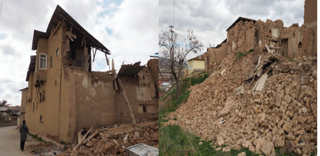
Balaban 2023 Deprem sonrası yıkılmış yapılar
