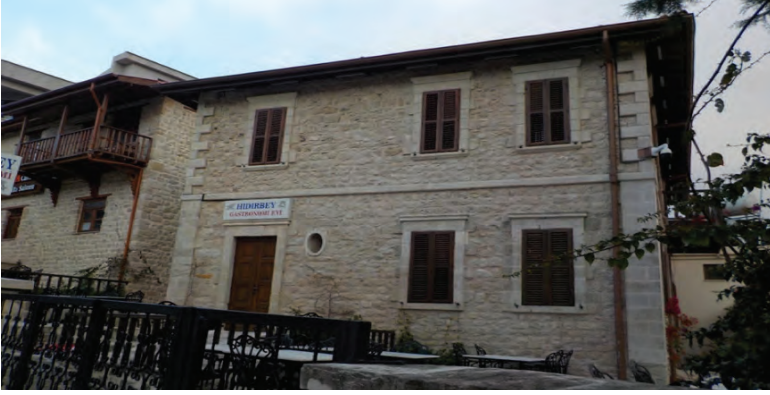
Hatay, Samandağ İlçesi, Hıdırlı Köyü, restore edilmiş yapılar
