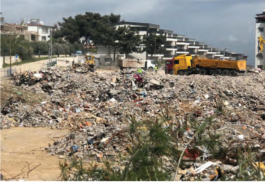
İskenderun Sarımazi döküm sahası (yerleşim yerinin ortasında, tarım alanları ve İskenderun içme suyunun karşılandığı yeraltı suyu havzası beslenmesi üzerinde)
