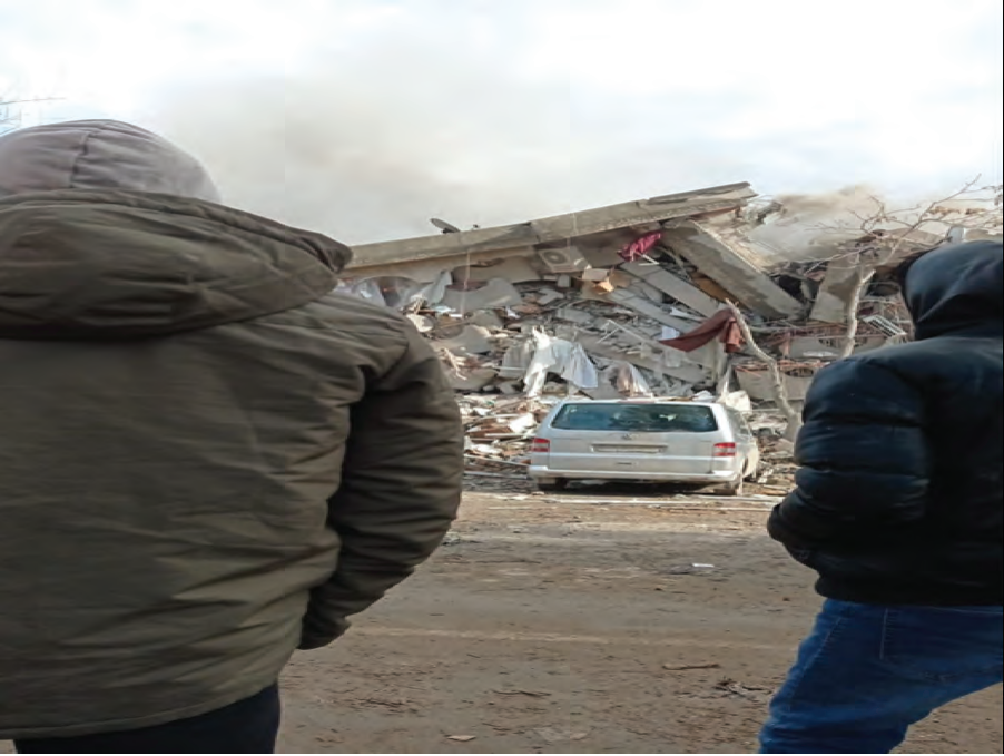
Kahramanmaraş Azerbaycan Bulvarı Buket Sitesi
