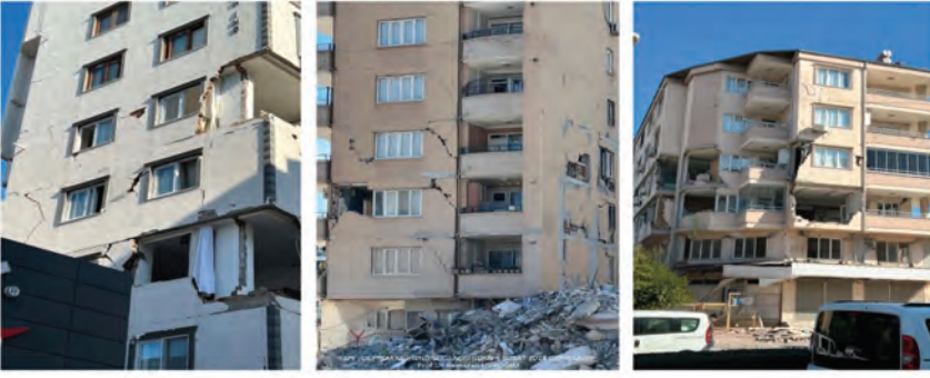
AFAD-Kahramanmaraş Depremi iller icmalı (8 Mart 2023) Yapısal olmayan bina hasarları örnek
