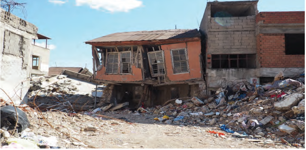
Kahramanmaraş merkez, zemin katı ahşap hatıllı yığma taş, üst katı ahşap karkas yapı
