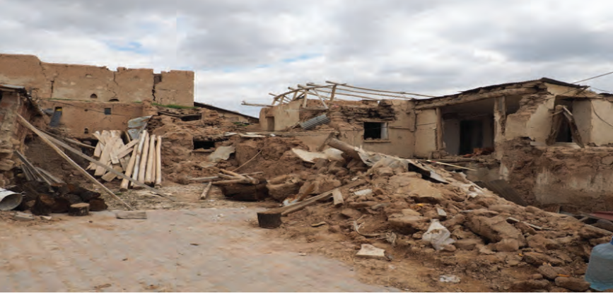
Balaban Ağır hasarlı kerpiç yapılar. Kullanıcılar, yıkılan yapıların ahşap kirişlerini toplayarak tekrar kullanmak ya da satmak için kenara diziıyor.
