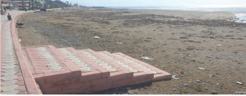
Şekil 4: Samandağ, Çevlik Balıkçı Barınağı güneyinde kıyıda su baskını izleri
