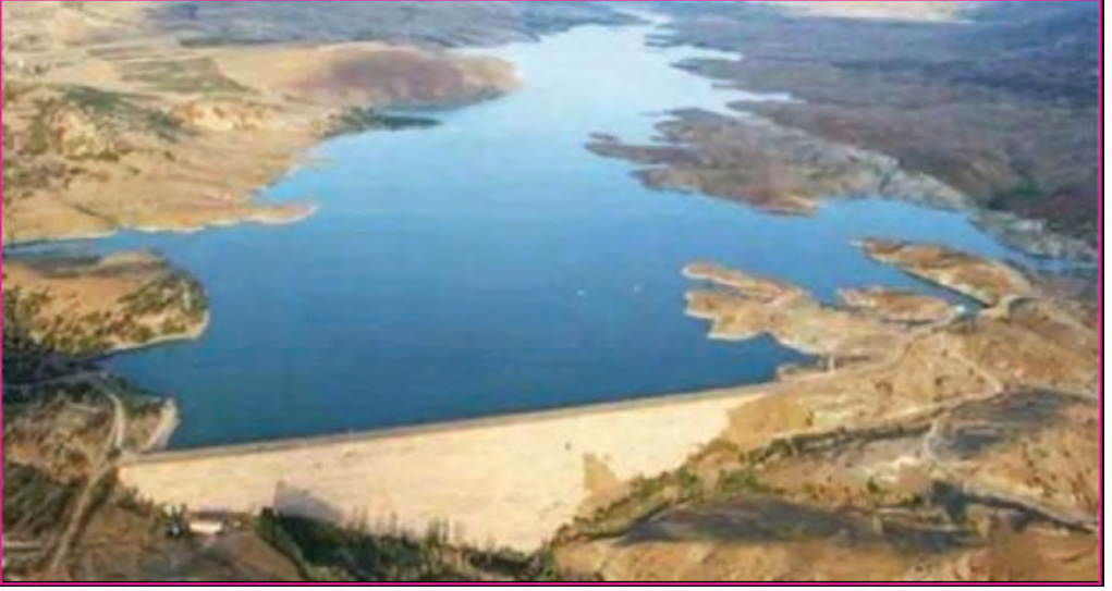
Şekil 9- Sürgü barajı dolgusu ve rezervuarı
