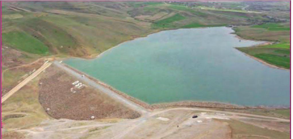
Şekil 19- Polat Barajı dolgu ve rezervuarından bir görünüm
