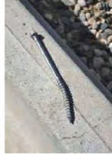
Çatı örtüsünün beton aşıkla yetersiz bağlantısı ve açık uç bağlantısında dolgu harçsız uygulama
