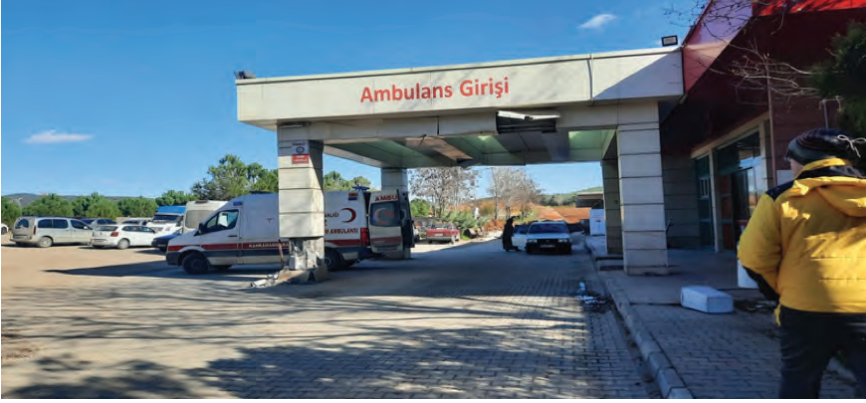
Kahramanmaraş Şehir Hastanesi
