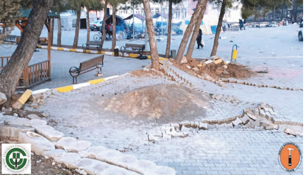
Şekil 12i: Yunus Emre Ortaokulu girişinde yüzey yırtılması izleri. Konum için Şekil 12f'ye bakınız.
