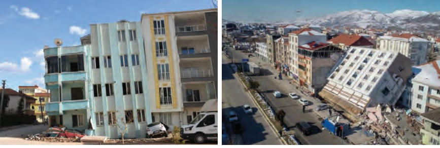
Şekil 43. Zemin sıvılaşması nedeniyle hasar almış binalar
