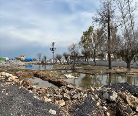
Şekil 7: İskenderun Balıkçı Barınağı ve arkasındaki bölgede kıyı çökmesi ve çöken alanda su birikmesi
