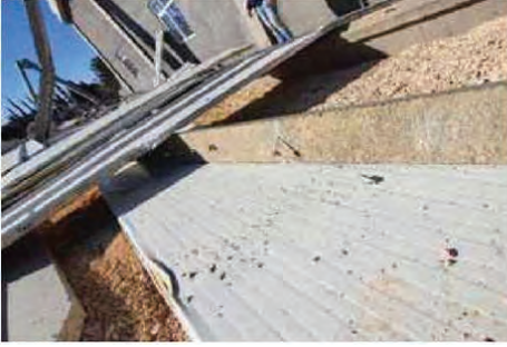
Çatı örtüsünün beton aşıkla yetersiz bağlantısı ve açık uç bağlantısında dolgu harçsız uygulama
