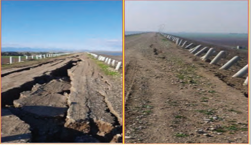
Şekil 42- Reyhanlı Barajı dolgusundan görünümler
