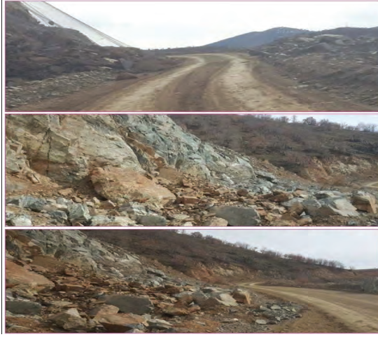
Şekil 23- Kandil barajı bağlantı yollarındaki kaya düşmeleri (sol)
