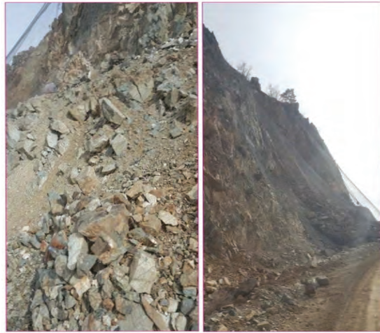
Şekil 24- Kandil barajı bağlantı yollarındaki moloz akmaları (sağ)
