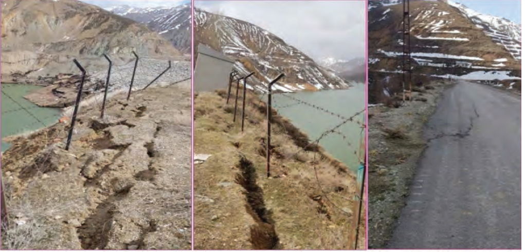
Őekil 14- Çat Barajı kretinde kayma yzeyi boyunca gzlenen hareketler
