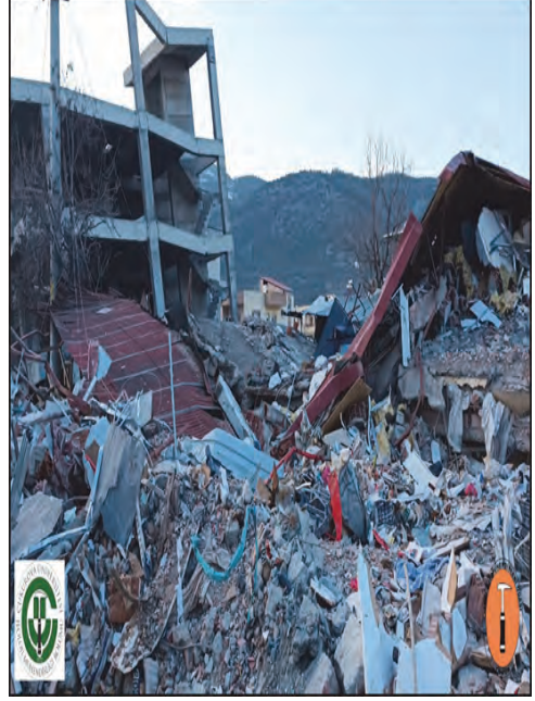
Şekil 12g: Şekeroba merkezde Akçakoyunlu Caddesi ve park alanında yüzey yırtılması ve arka planda göçük binalar.
