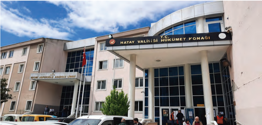
Necmi Afsuroğlu Anadolu Lisesi - Antakya Valilik Binası olarak kullanılmaktadır.
