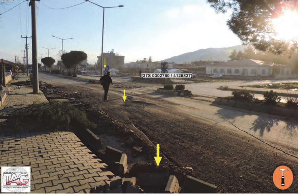
Şekil 12c: Şekeroba merkezde Belediye Caddesinde yüzey yırtılması. Konum için Şekil 12e'ye bakınız.
