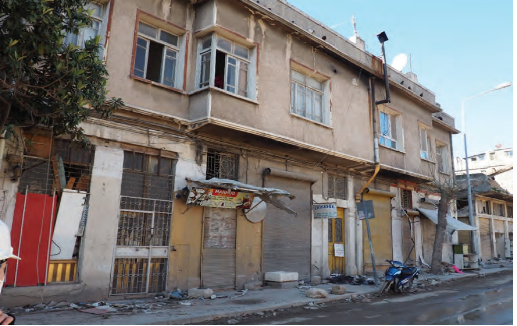
Kurtuluş Caddesi, olasılıkla 1930-40'lı yıllara tarihlenen yığma tuğla duvarlı, betonarme döşemeli yapı
